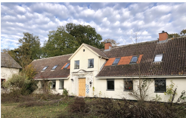
Stuehuset, som er ansøgt nedrevet.
